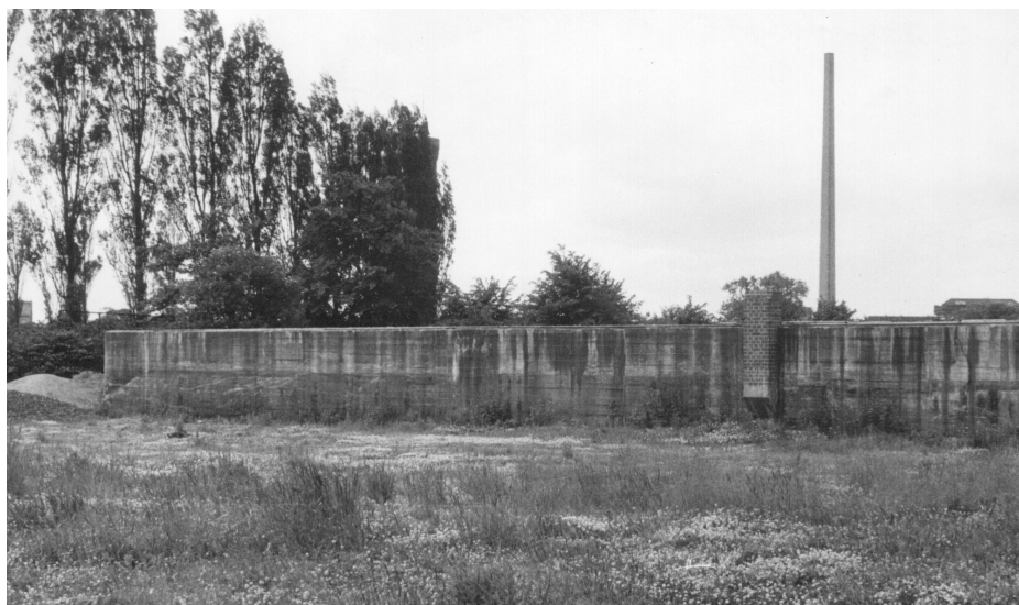
Bunker der Hamburger Wasserwerke, in dem die italienischen Militärinternierten untergebracht waren, undatiert. (Hamburg Wasser)
