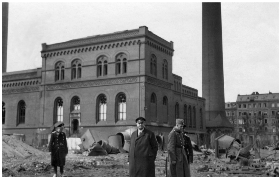
Das Hauptpumpwerk der Hamburger Wasserwerke in Rothenburgsort, 1943. (Hamburg Wasser)
